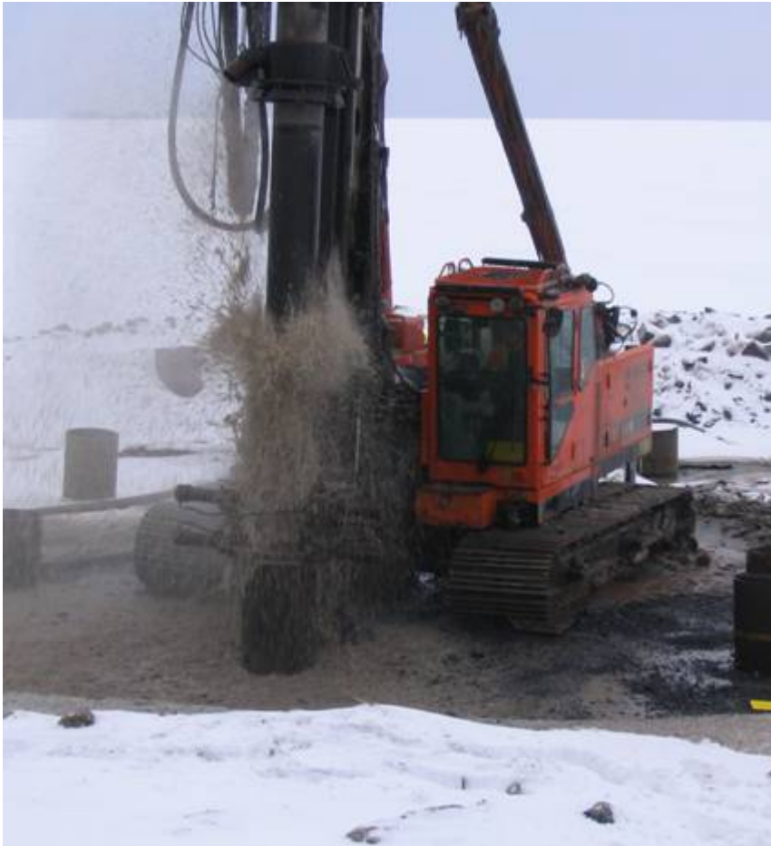
Junttan PM16 - RD610/12.5 porapaalujen asennus
